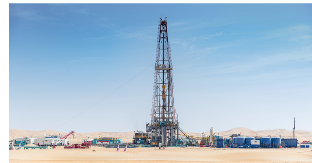
Al Dhafra Petroleum 광구 내 Haliba 유전 시추 현장
