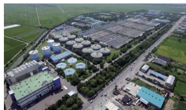
부천 굴포하수처리장 미활용에너지 회수사업
